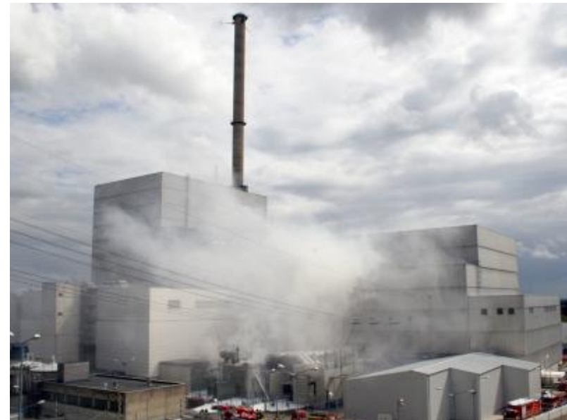
Transformatorenbrand in Brunsbüttel Foto: ndr
