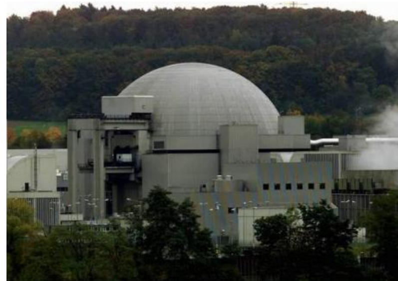
Droht ein Sicherheitsrisiko im AKW Neckarwestheim wegen minderwertigem Beton? Foto: ddp
