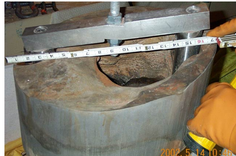
Korrosionsschaden Reaktordruckbehälter Davis Besse
